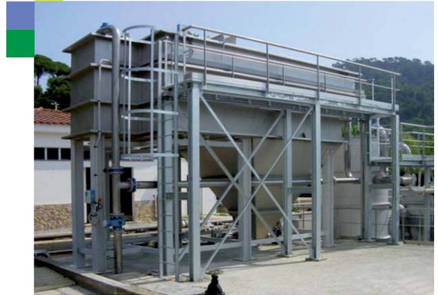
El rango de caudales varía en función de cada caso (aplicación, concentración de sólidos en suspensión, etc.), pero **ECOTEC** puede suministrarlos para caudales de hasta 300 m<sup>3</sup>/h.
